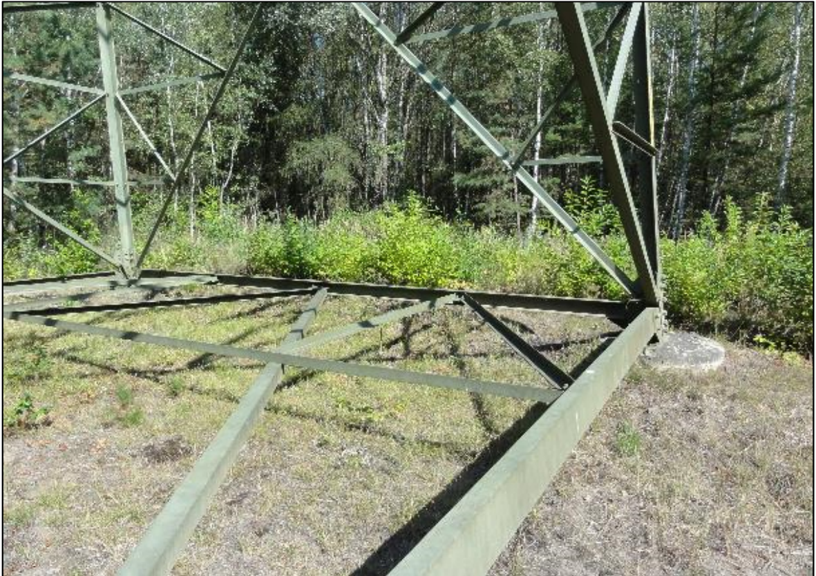
Abbildung 3: Fläche mit Habitateignung am Mast 93, 23.08.2019
