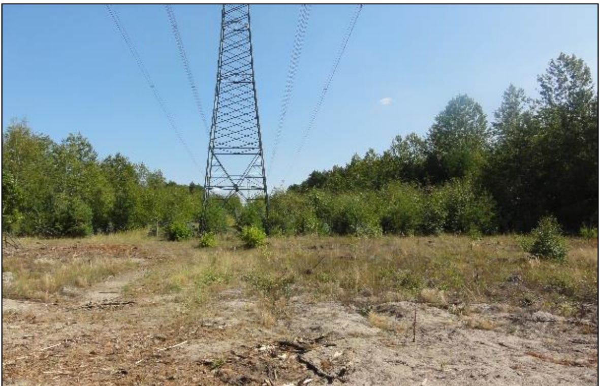
Abbildung 2: Fläche mit Habitateignung am Mast 90, 06.09.2019
