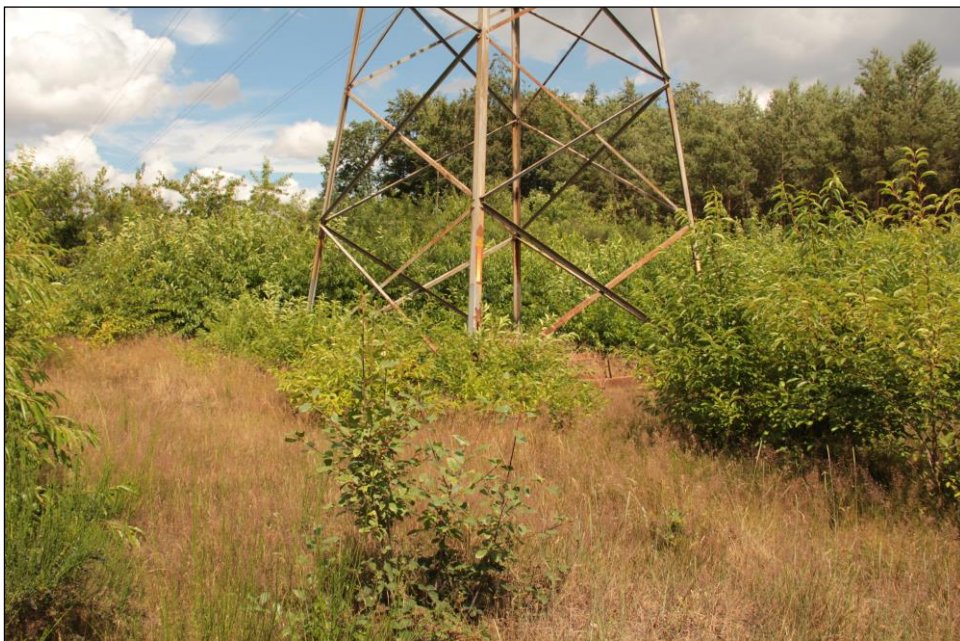
Abbildung 14: Bereich zwischen Mast 20 und 21 (Mast 21 im Hintergrund)
