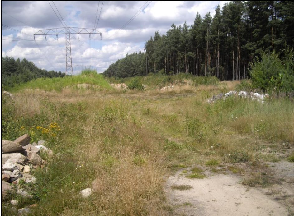
Abbildung 8: Bereich zwischen Mast 8 und 9
