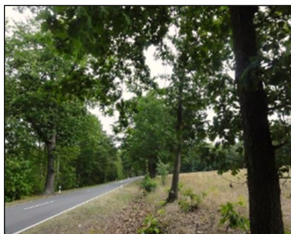
Abbildung 13: Allee an der L 52, Blick nach Süden (Aufnahme vom 12.09.2019)
