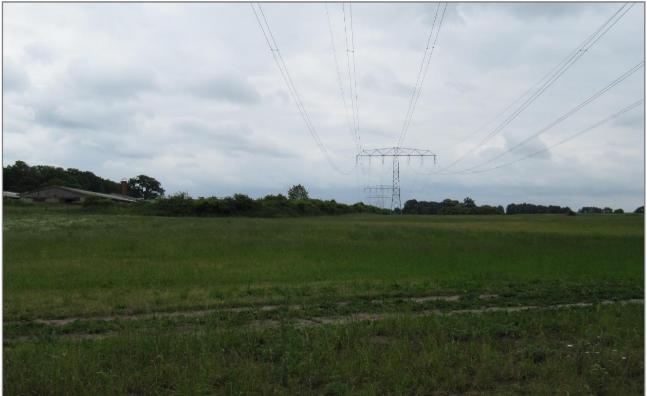
Abbildung 32: Leitungsverlauf bei Neuhofof am Landwirtschaftshof – Blick Richtung Süden auf Mast 43alt
