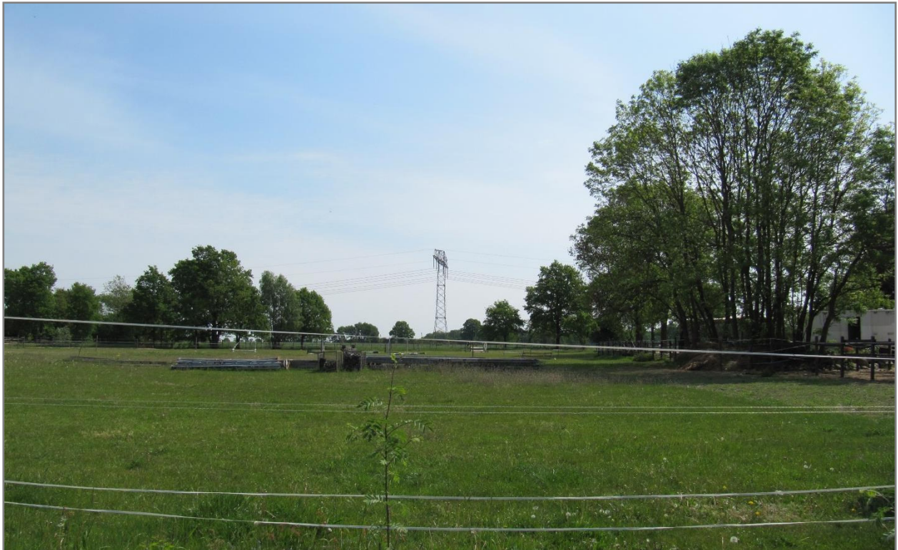
Abbildung 31: Blick auf Mast 39alt der 220-kV-Freileitung vom Weg westlich des Pferdehofes in Wittmoor
