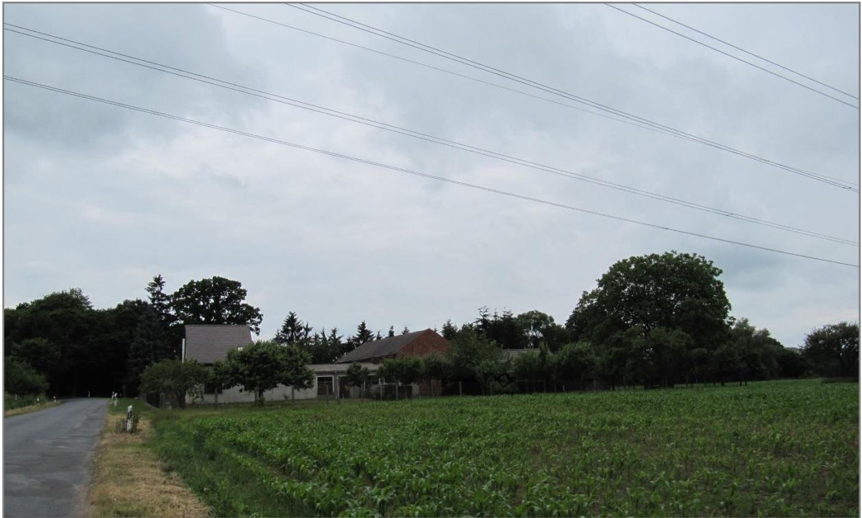
Abbildung 34: Einzelanwesen in 45 m Entfernung zur Leitung nahe des Winkelmastes 48alt
