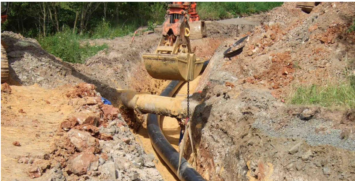
Abbildung 5.6-1: Offene Kreuzung eines verrohrten Grabens
