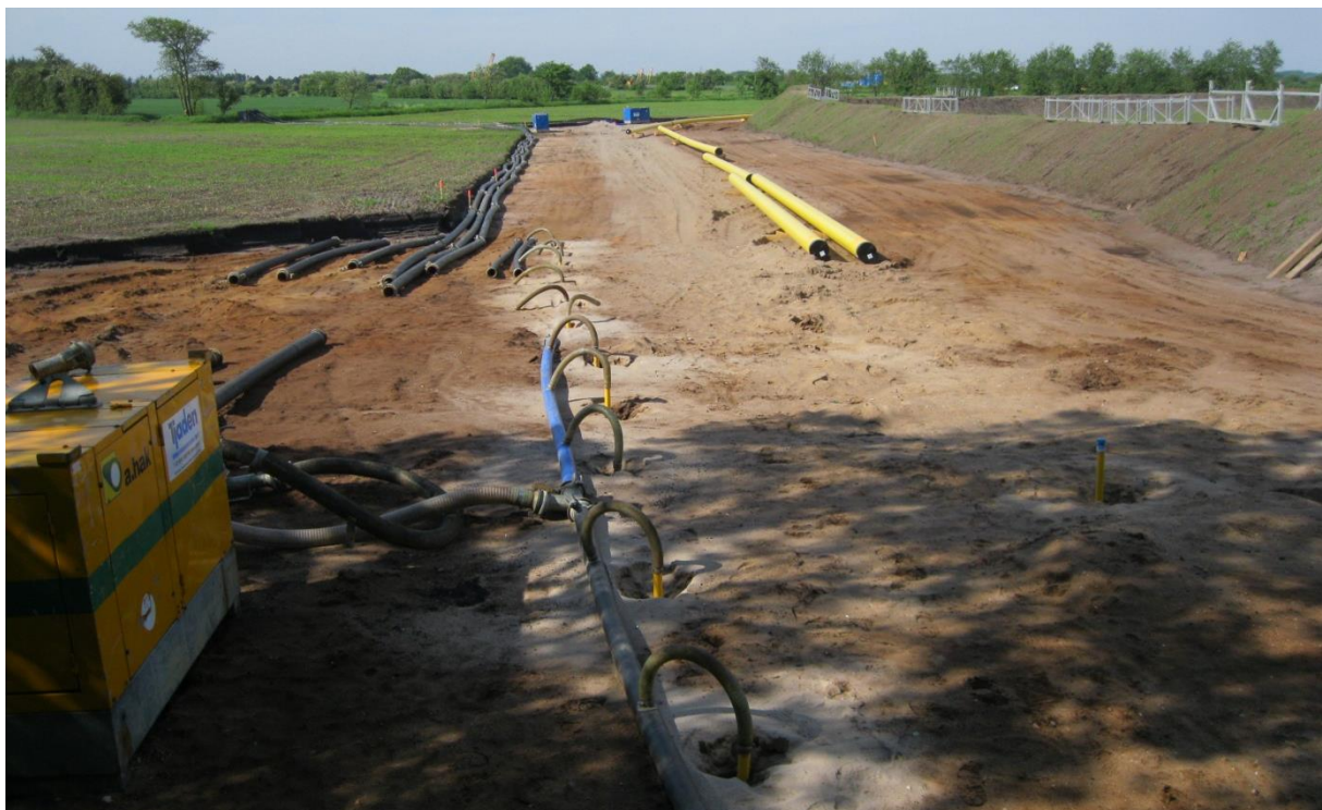
Abbildung 5.4-3: Wasserhaltung mit Spülfiltern
