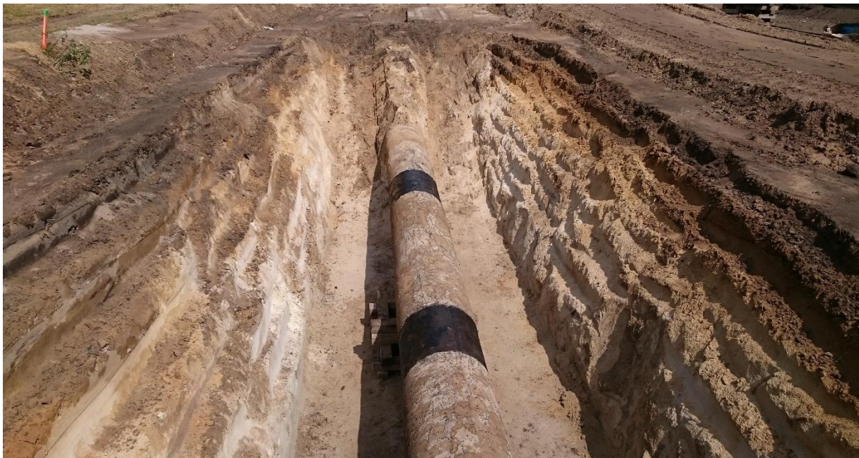
Abbildung 5.4-4: Freilegen der Altleitung
