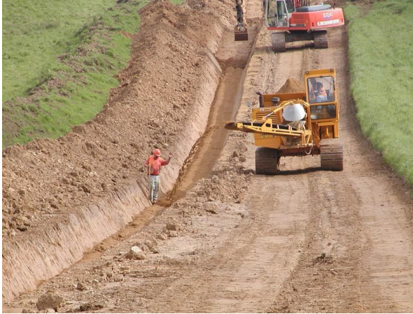
Abbildung 5.4-10: Verfüllen des Rohrgrabens
