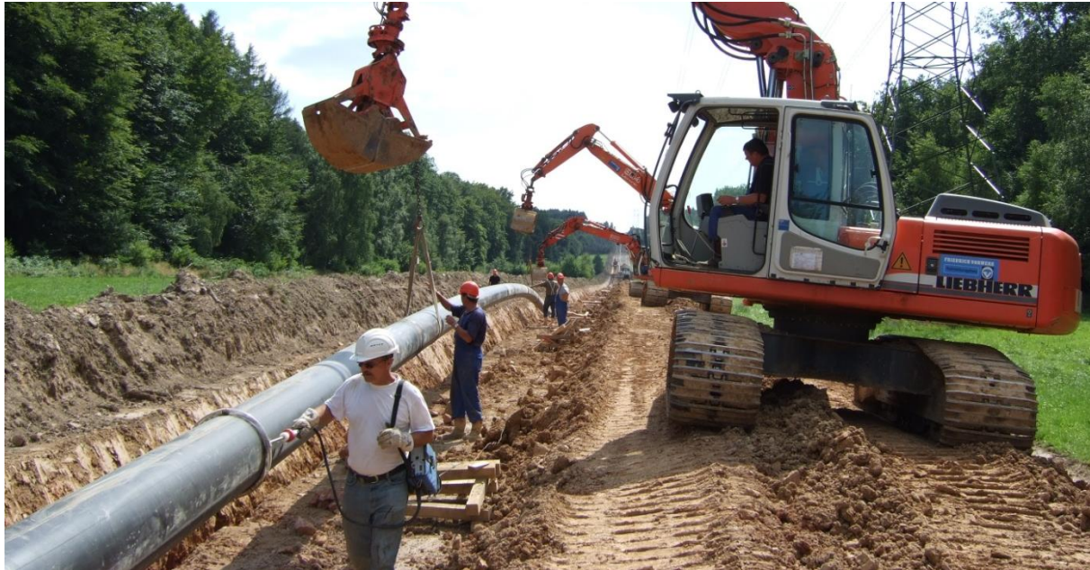
Abbildung 5.4-8: Absenken des Rohrstranges und Isotest
