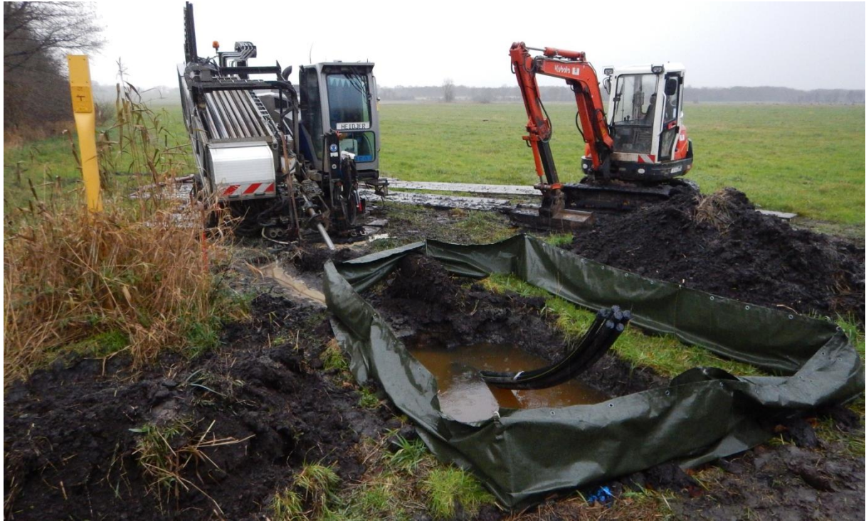
Abbildung 5.6-6: HDD-Rig bei der Kabelverlegung
