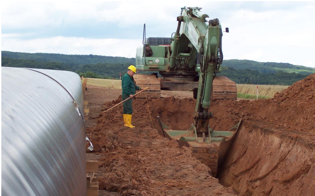
Abbildung 5.4-7: Herstellung des Rohrgrabens
