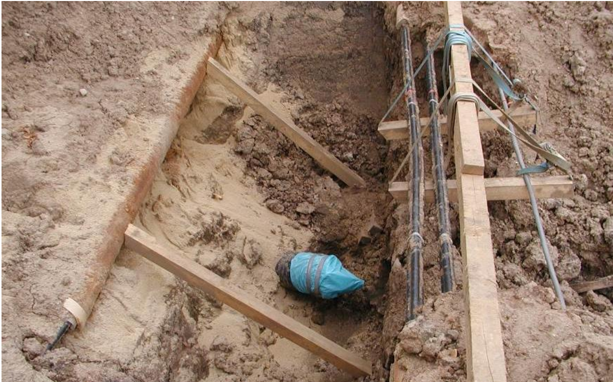
Abbildung 5.5-1: Sicherung von Fremdleitungen (Kabel)
