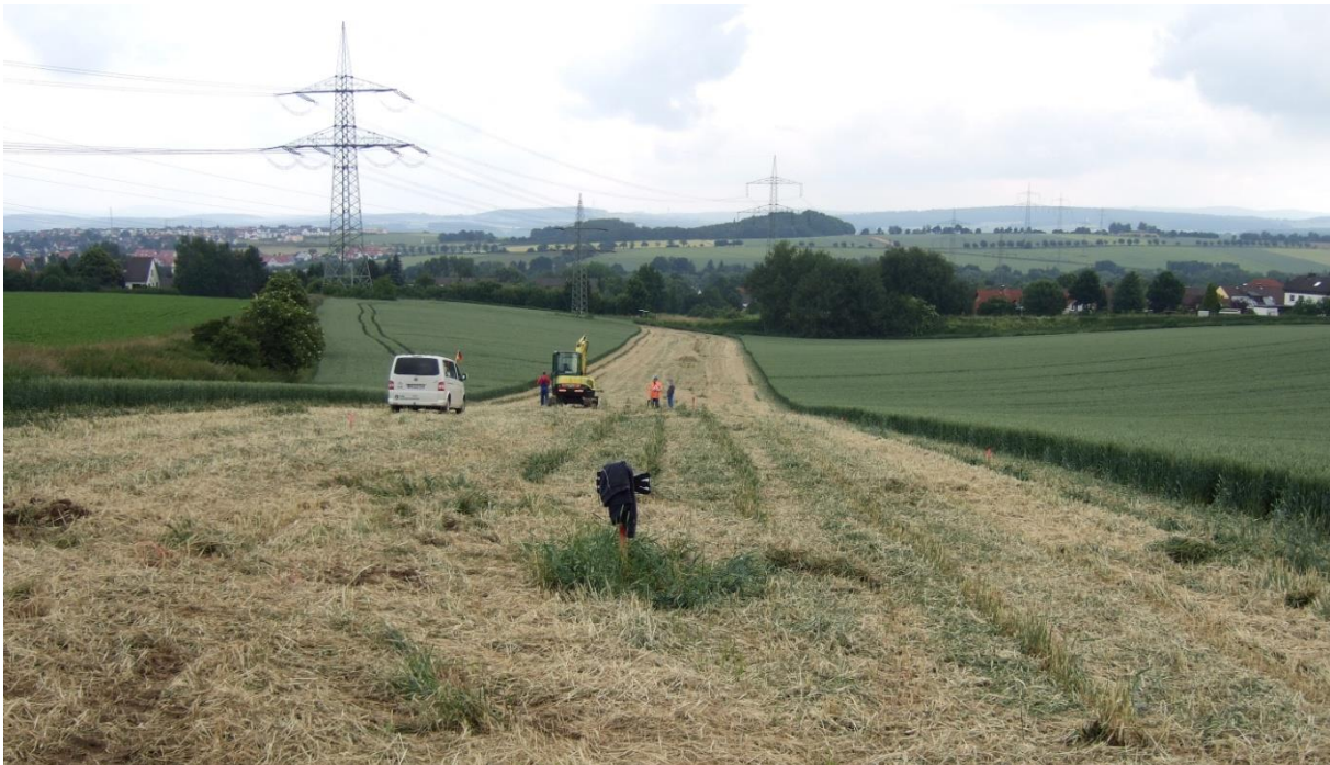
Abbildung 5.4-1: Räumen der Trasse
