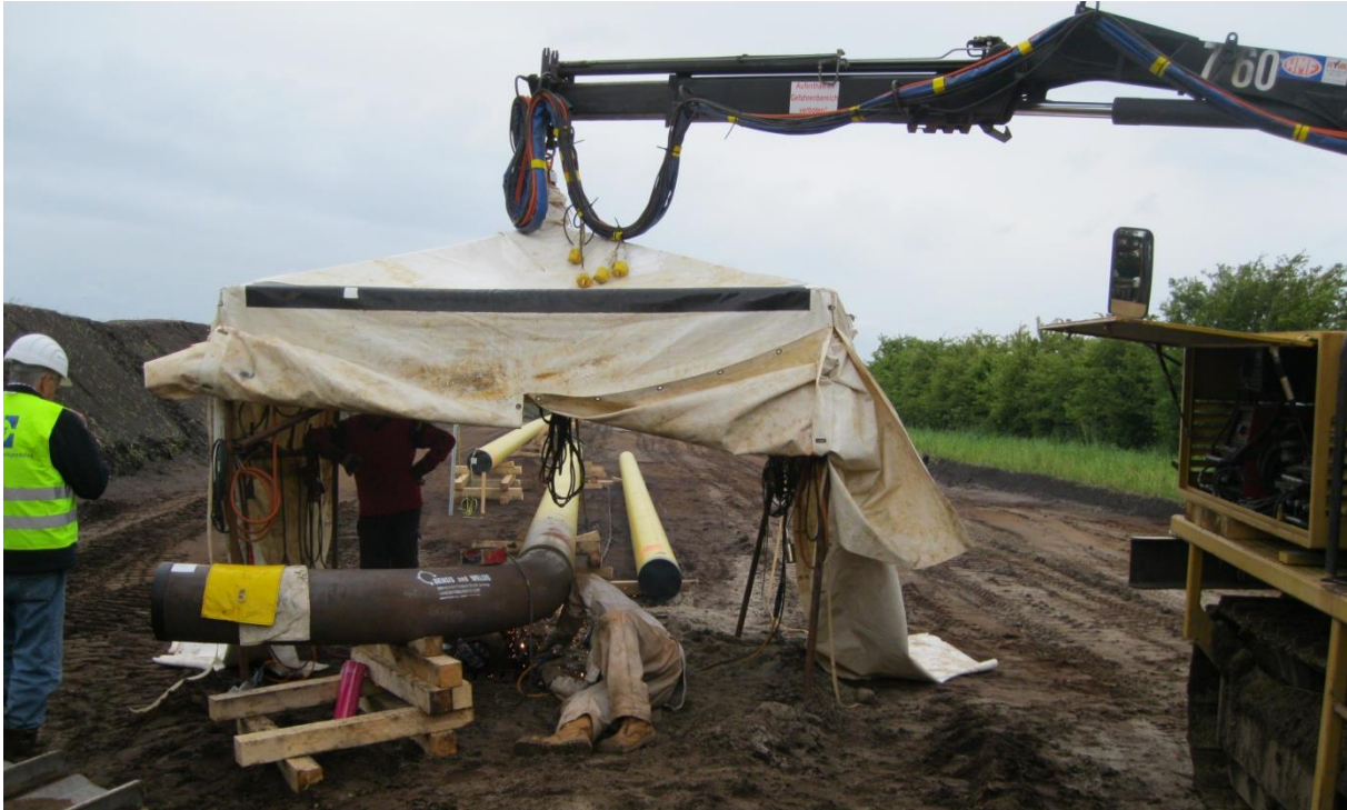
Abbildung 5.4-6: Verschweißen der Rohre
