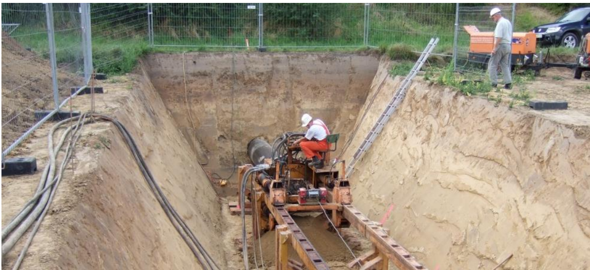
Abbildung 5.6-2: Horizontal-Pressbohrverfahren (Startgrube)
