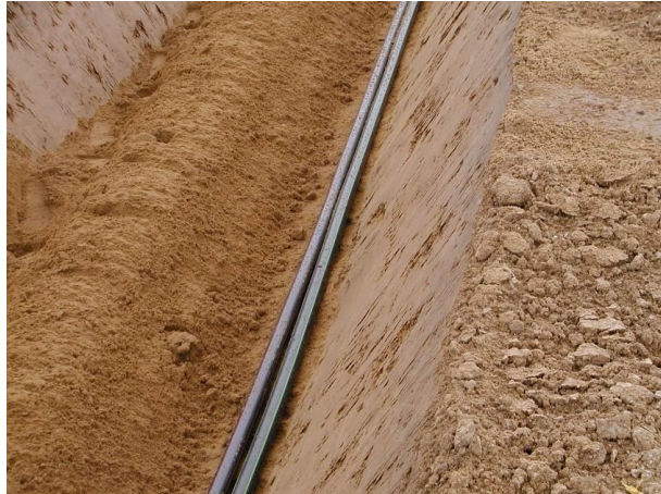
Abbildung 5.4-9: Verlegung der Kabelanlage
