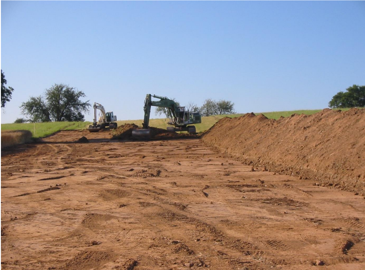
Abbildung 5.4-2: Mutterbodenabtrag
