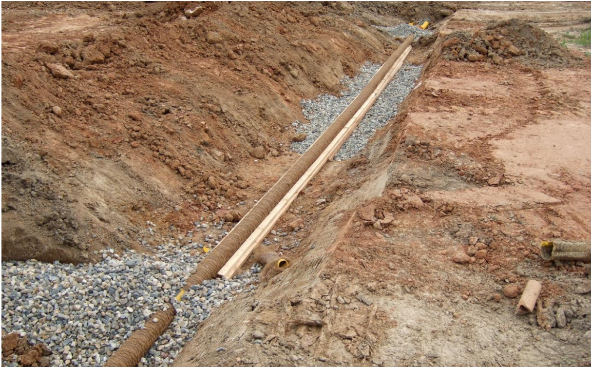
Abbildung 5.4-11: Wiederherstellung einer Dränanlage
