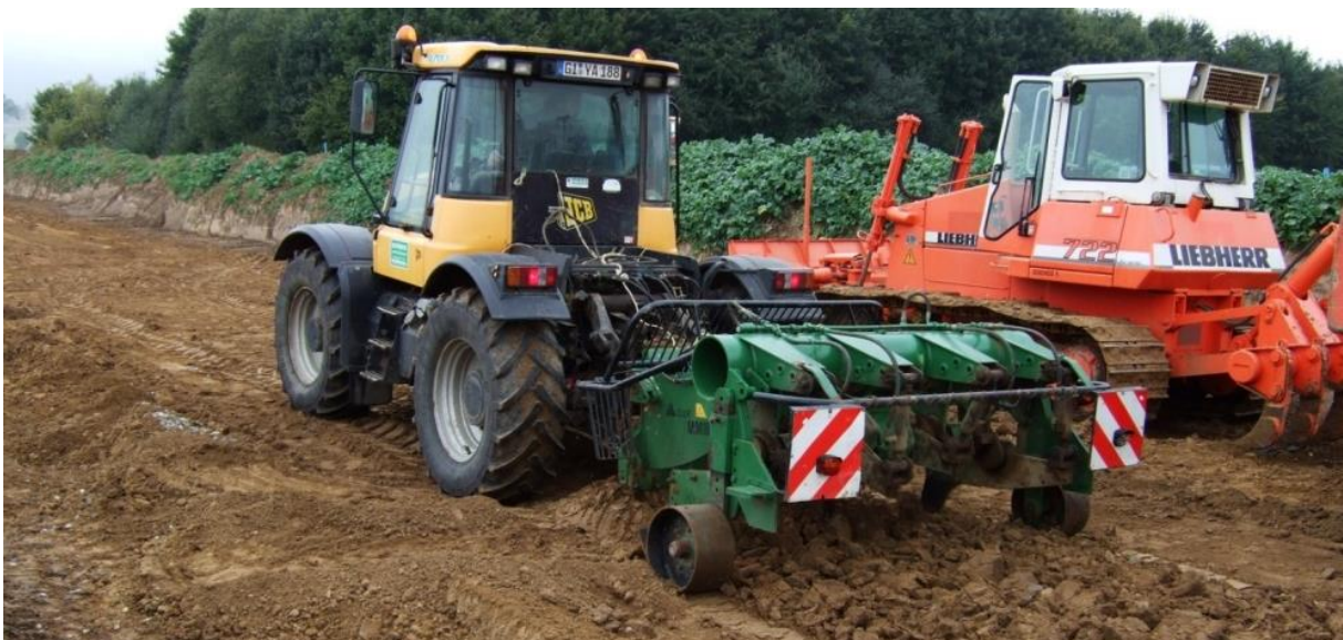
Abbildung 5.4-12: Lockerung des Unterbodens
