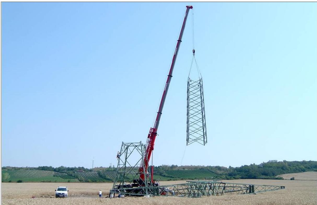
**Abbildung 9: Maststocken mittels Mobilkran (Quelle: 50Hertz)**
