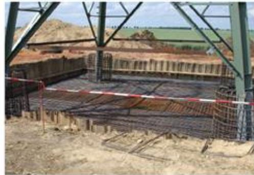
**Abbildung 5: Beispiel eines Plattenfundamentes (Quelle: 50Hertz)**
