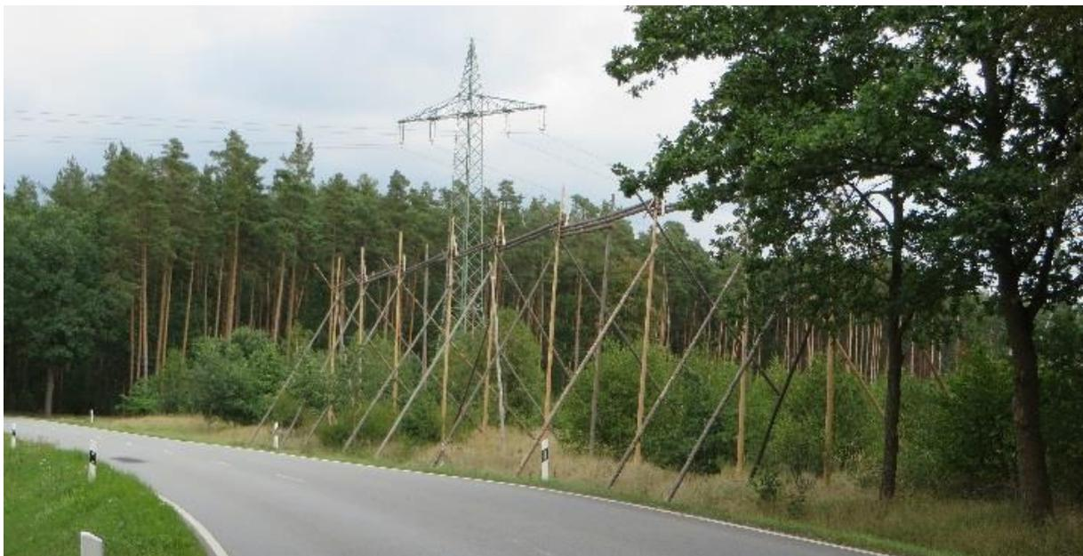
Abbildung 10: Schleifgerüst für Seilzug (Quelle: 50Hertz)
