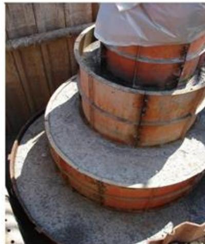
**Abbildung 6: Beispiel eines Stufenfundamentes (Quelle: 50Hertz)**
