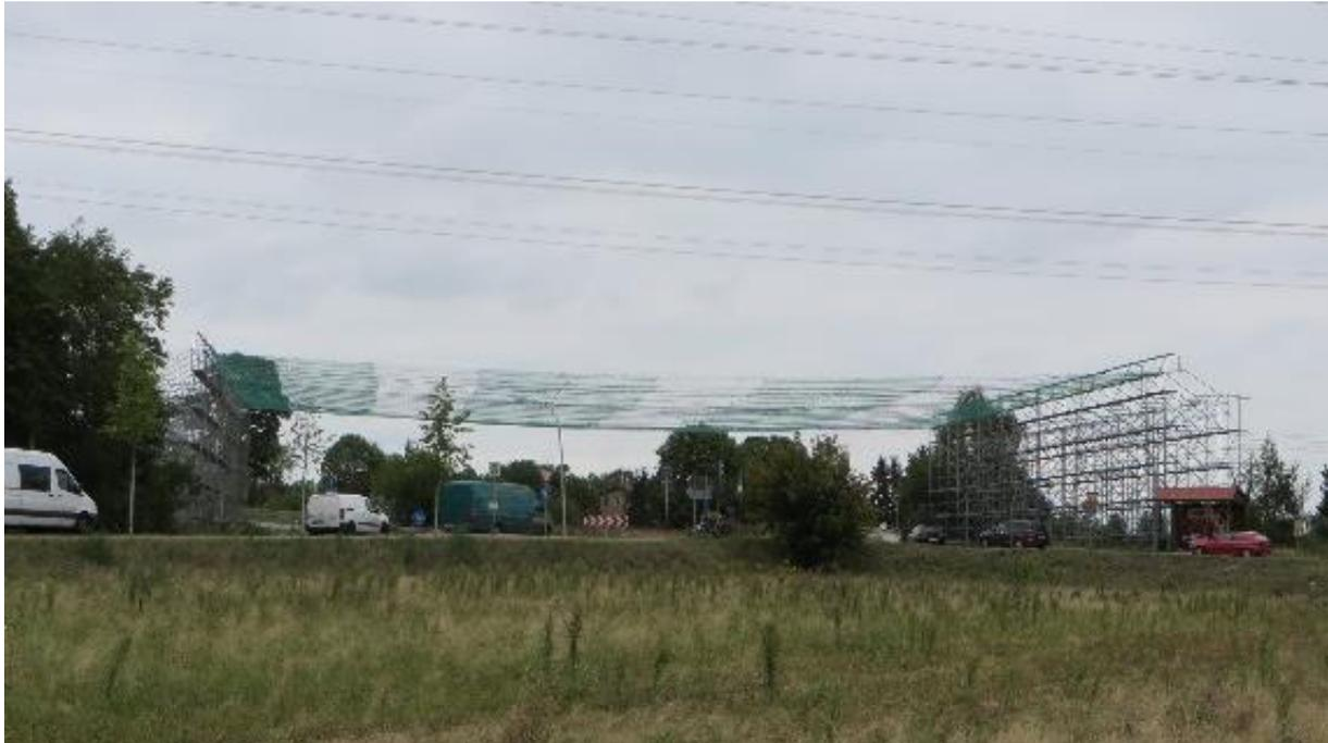
**Abbildung 11: Schutzgerüst mit Netz für Seilzug (Quelle: 50Hertz)**
