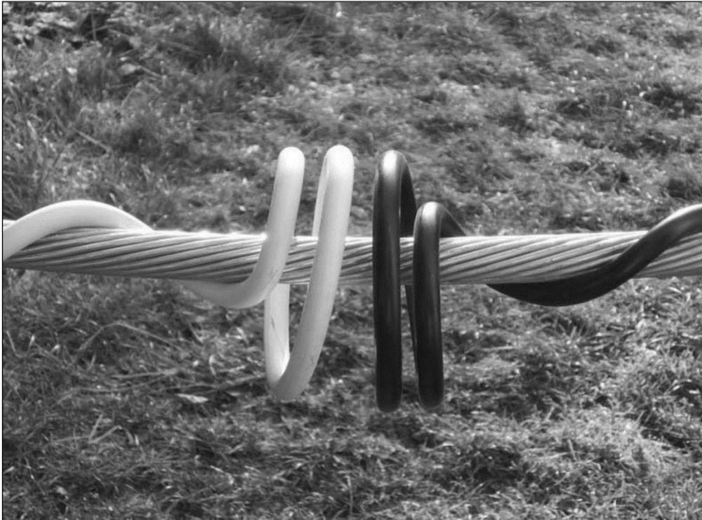
**Abbildung 10: Vogelschutzmarker (Quelle: 50Hertz)**
