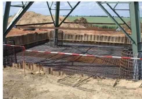
Abbildung 7: Beispiel einer Plattengründung (Quelle: 50Hertz)
