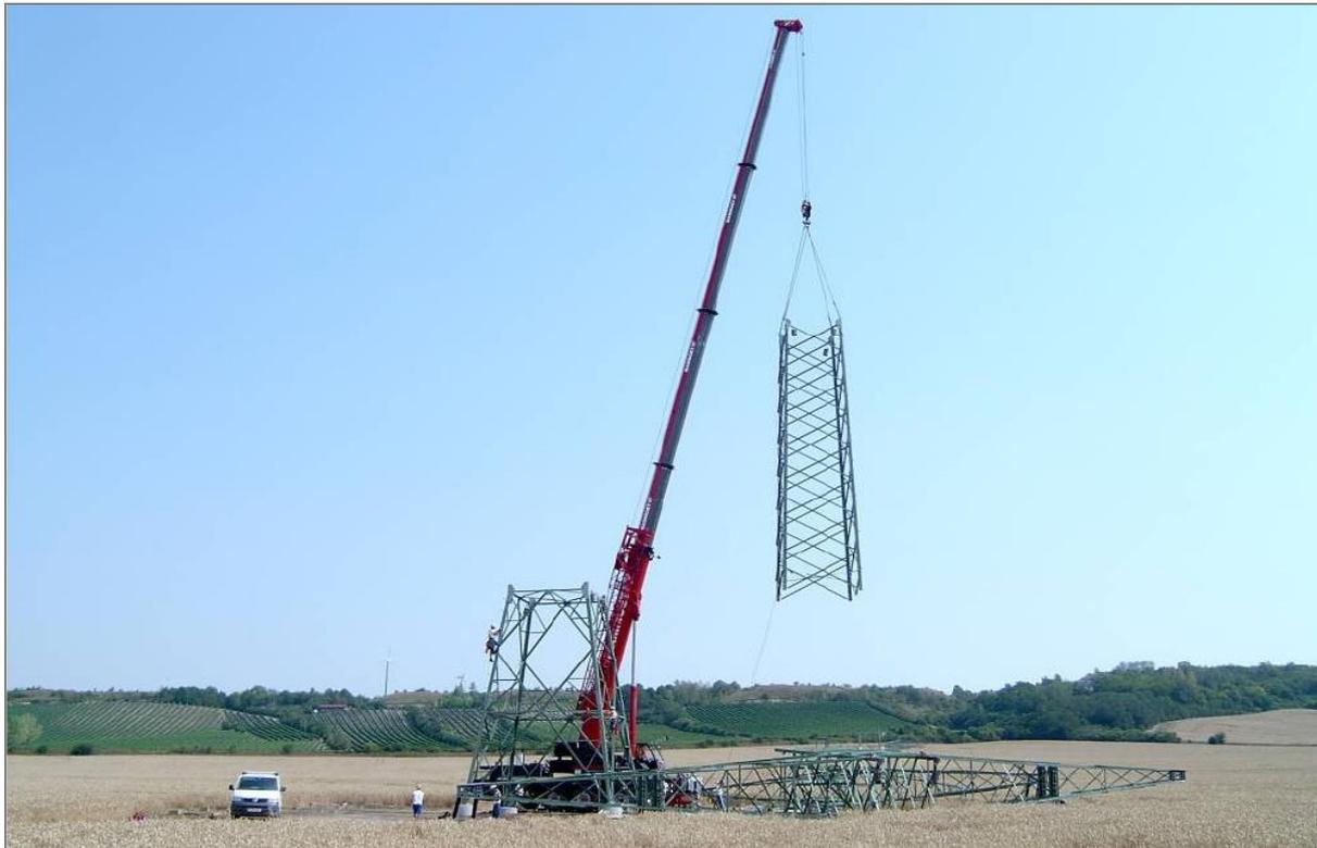
**Abbildung 11: Maststocken mittels Mobilkran (Quelle: 50Hertz)**
