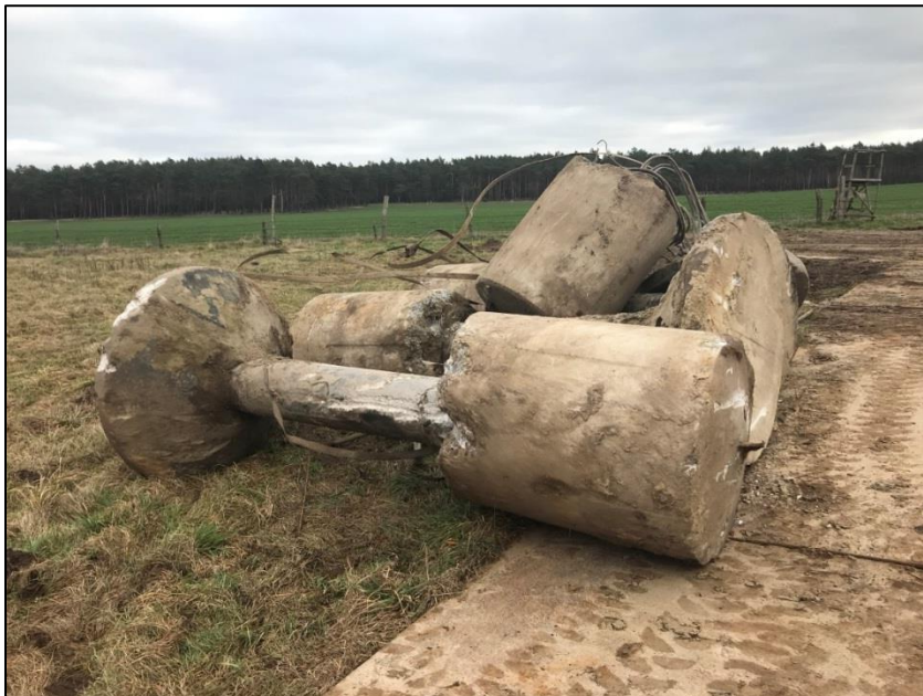
Abbildung 11: Pilz-Fundament der 220-kV-Bestandsleitung (Quelle: 50Hertz)
