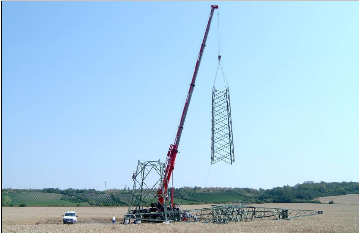
Abbildung 9: Maststocken mittels Mobilkran (Quelle: 50Hertz)
