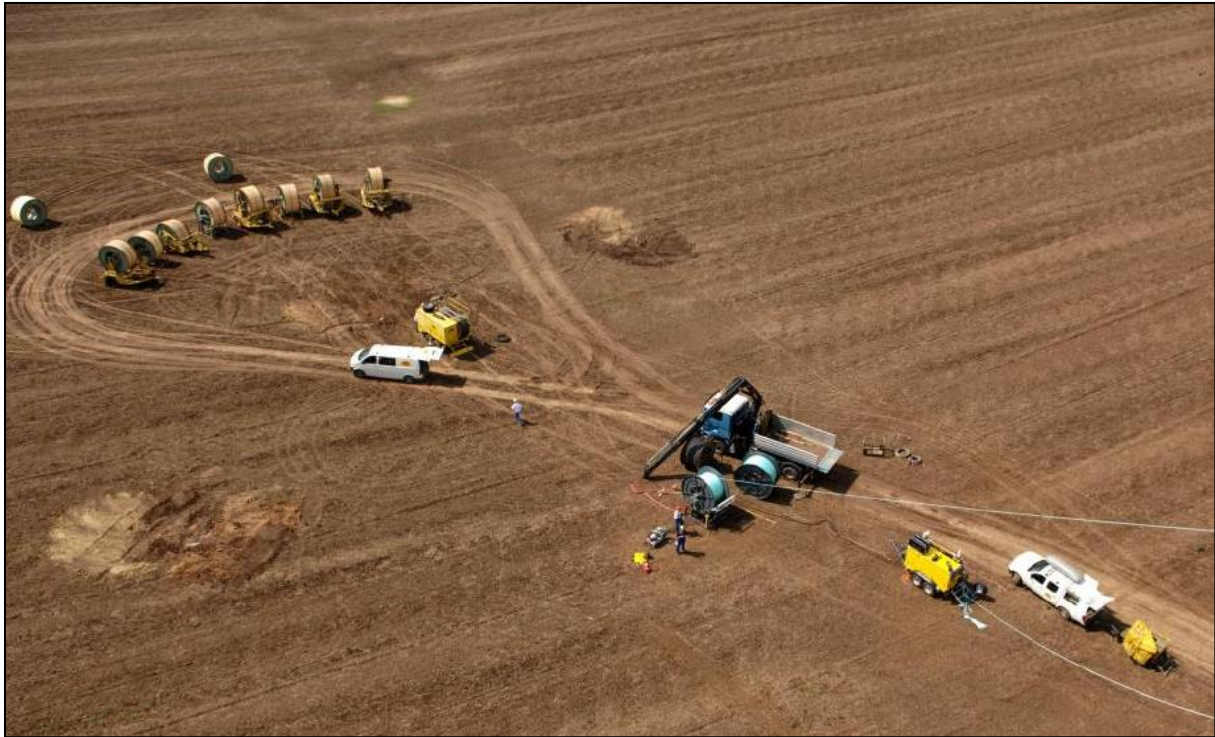
Abbildung 10: Winden- und Trommelplatz für Seilzug (Quelle: 50Hertz)
