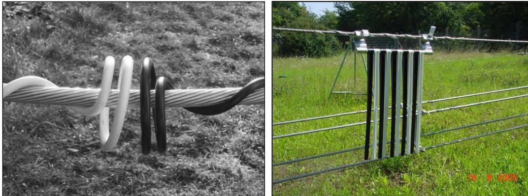
Abbildung 8: Spiralmarker (links) und Klappenmarker (rechts) (Quelle: 50Hertz)
