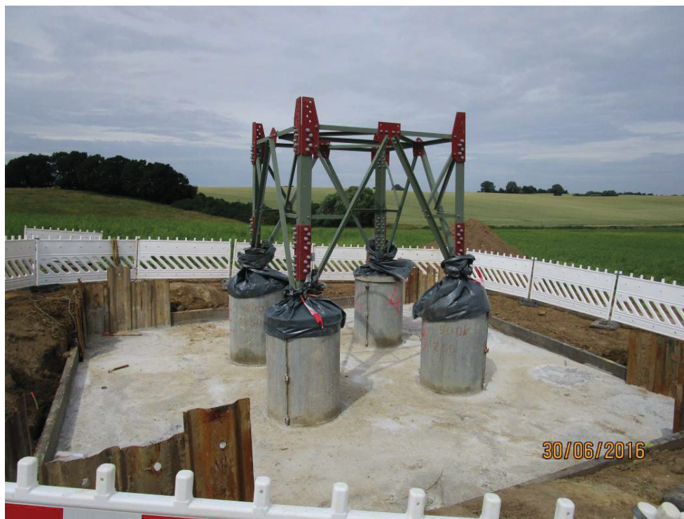
Abbildung 13 Baugrube mit Fundament (Beispiel)
