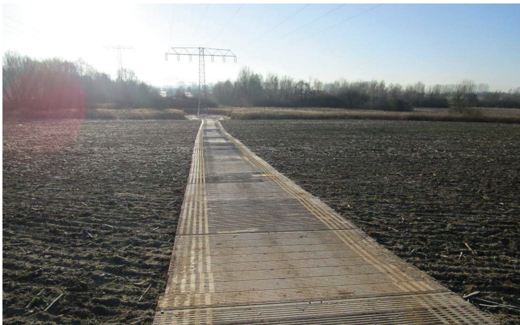
Abbildung 12 Beispiel einer Baustraße mit temporären Matten (Beispiel)
