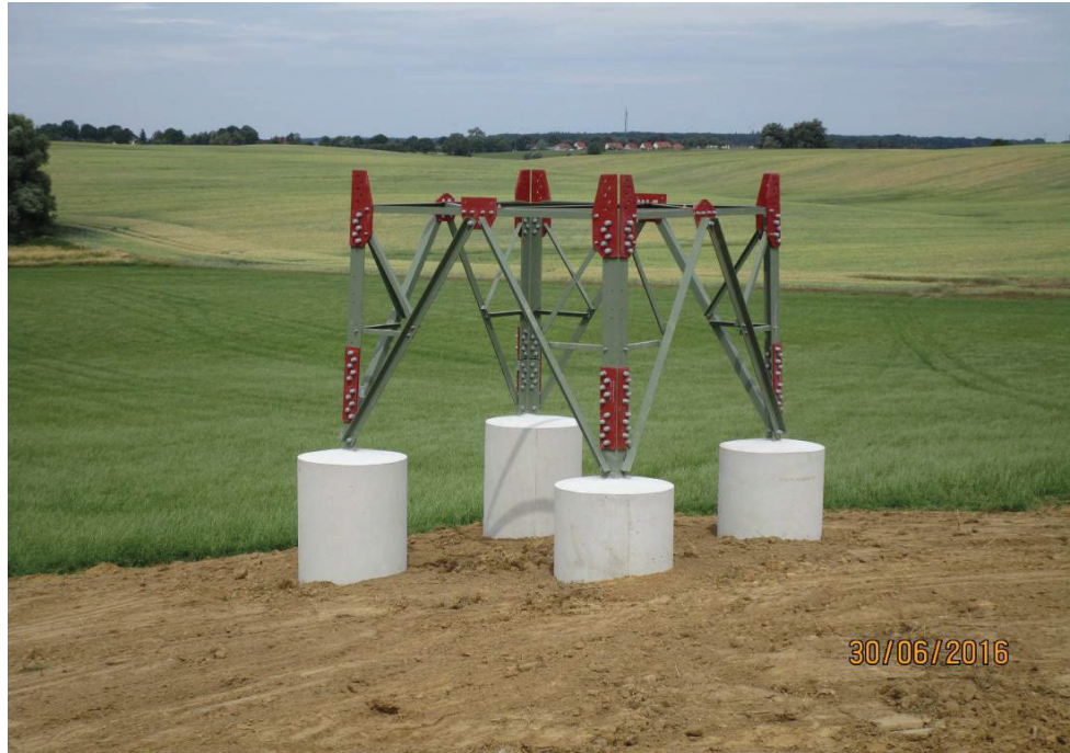
Abbildung 11 Beispiel eines wiederverfüllten Plattenfundamentes (Beispiel)
