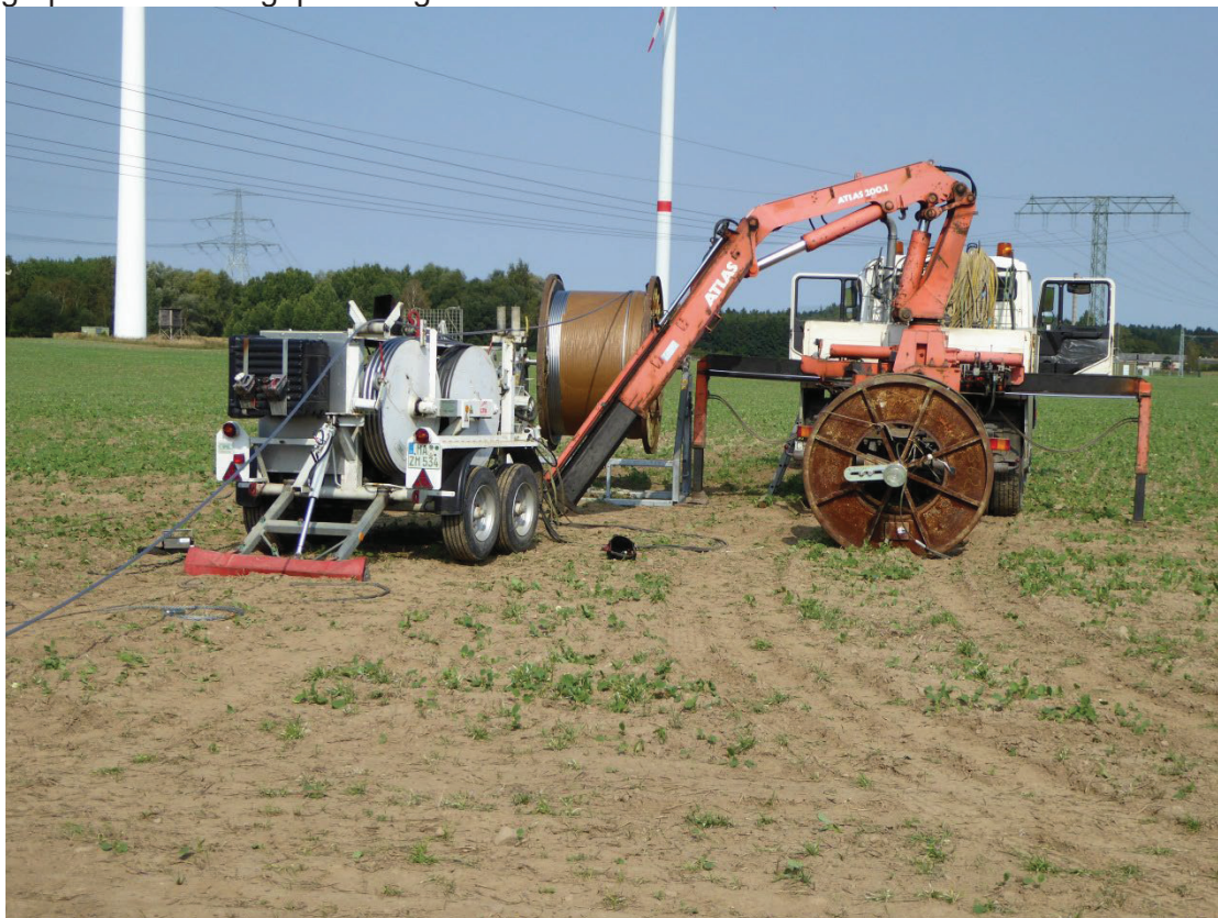
Abbildung 15 Aufstellplatz für Seiltrommel (Beispiel)
