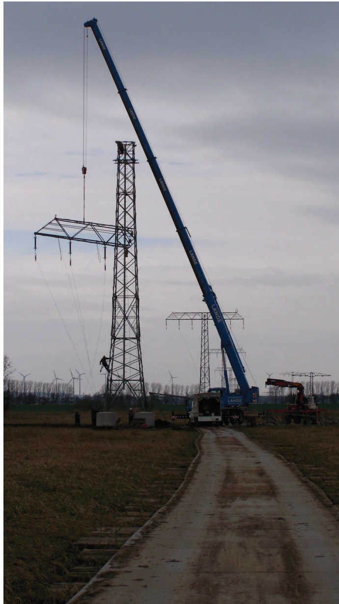
Abbildung 14 Maststellen mittels Autokrans (Beispiel)
